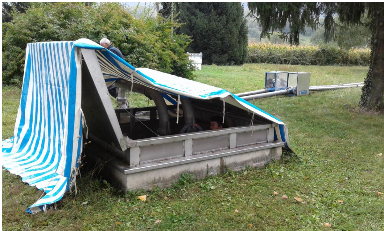
Illustration 31 : Mise en place du dispositif de pompage (Source : BRGM)
